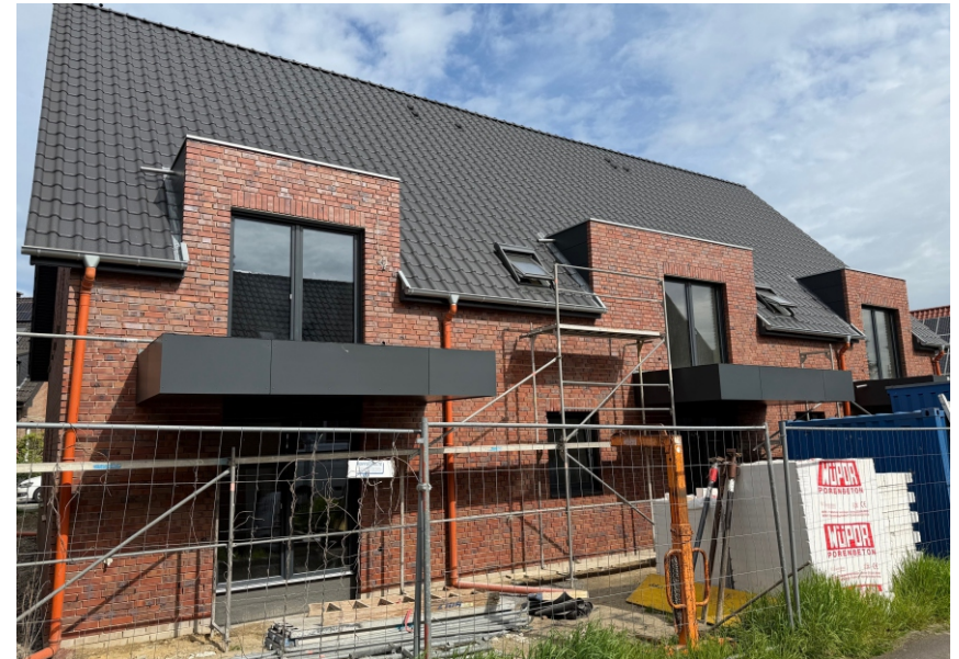
derzeitiger Bautenstand Mai 2026
